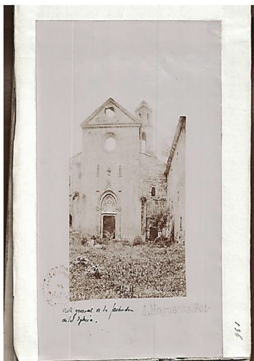
Vista general de la fachada de la Iglesia. (Fotografía: A. Jaén)
